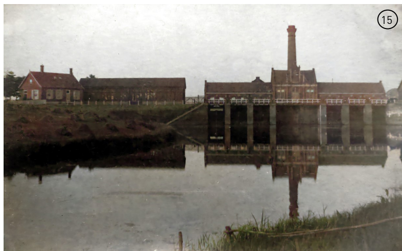
Het voormalige stoomgemaal aan de Engelsedijk
